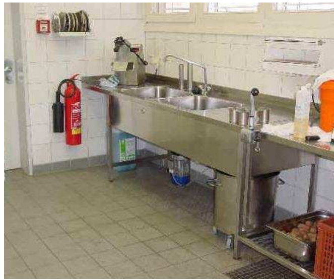
Intagsstation integrerad i kök förbundet med rör ner till stor tank och avvattningsenhet placerad i annat utrymme.
