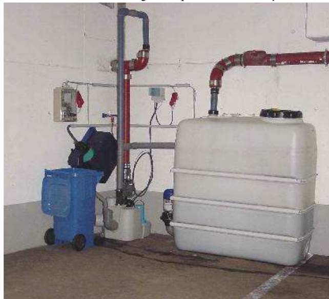
Intagsstation integrerad i kök förbundet med rör ner till stor tank och avvattningsenhet placerad i annat utrymme.
