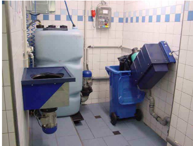
Intagsstation, tank och avvattningsenhet på samma ställe.
